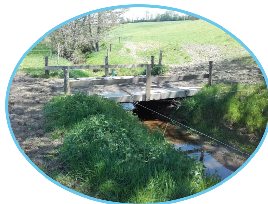
Pont, Exemple du Syndicat de la Bourbince, 2021
